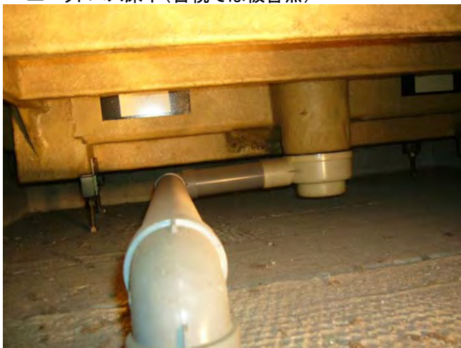
* ユニットバス床下(目視では被害無)
