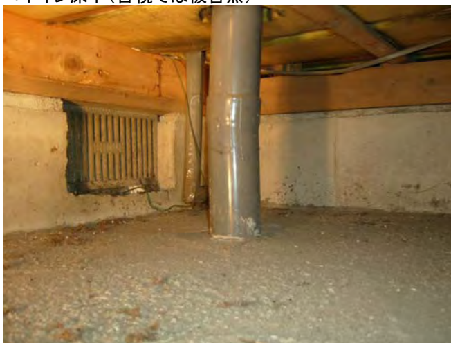
*トイレ床下(目視では被害無)
