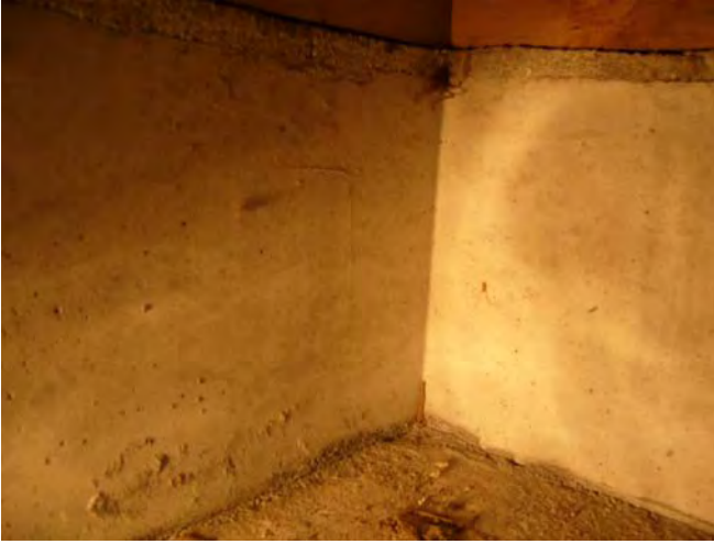
④居間北東角蟻道(土台まで到達せず)
