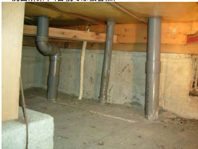
* 洗面所床下(目視では被害無)
